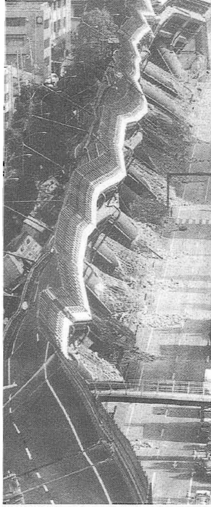
17 Ocak 1995, Kobe, Japonya'daki büyük depremde, Hansin otobanı kolayca eğildi. Yolun diğer tarafında tek destekli kolonların üzerinde şiddetli bir trafik kayması oluştu.
