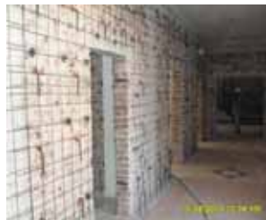
Resim 10, 11, 12. Yığma binada yapılan güçlendirmenin aşamaları
