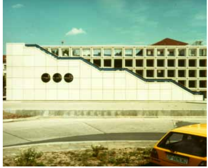
Resim 11: Kapalı otopark cephe elemanları, Braunschweig [24]
