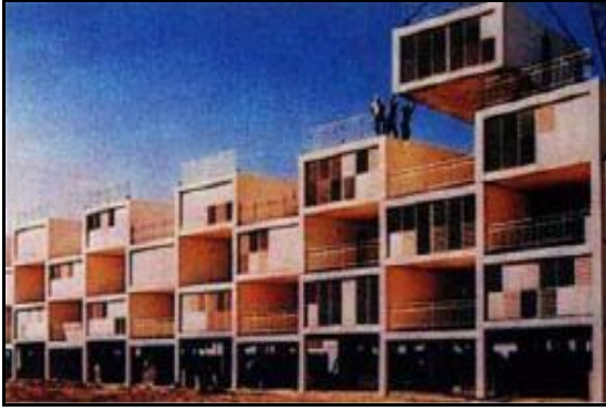
Resim 2: a) Hücre sistem uygulaması, b) Japonya'da prefabrike konutlar [13]
