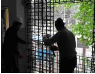
Resim 7, 8, 9. Demir donatılar projesine uygun şekilde hazırlanmıştır.
