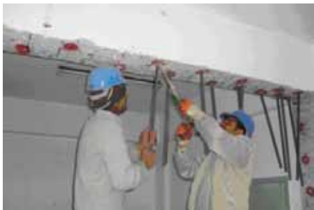
Resim 4, 5, 6. Demir çubuk ekimi yapıldıktan sonra demir çubuklara ankraj çekme testi uygulanmıştır.
