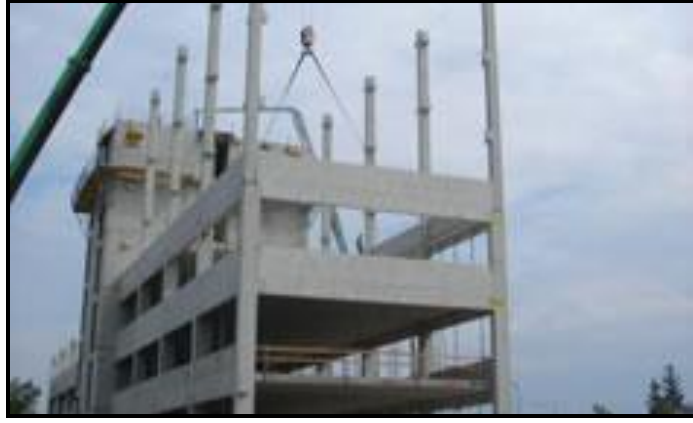
Şekil 2: Ön üretilmi iskelet sistem elemanları ve çok katlı kolon uygulaması [7,8]
