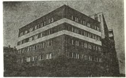
TSE, Sitesi açılmadan önce, Kızılay'daki İngiliz Kültür Heyeti Binasının 3. katını işgal ediyordu
